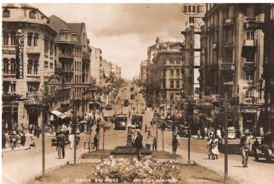
Avenida São João
