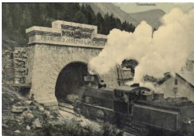
Tunel entre Bad Gastein e Mallnitz.
